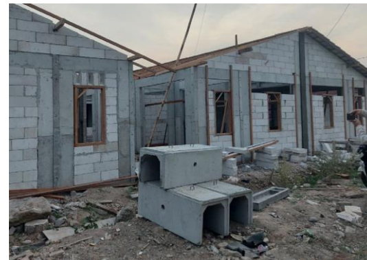
Pembangunan Rumah dengan Teknologi Ruspip
