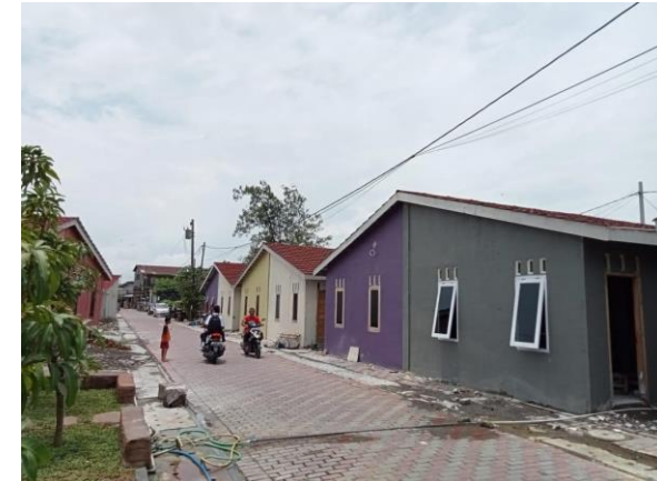
HP0001, Semanggi Setelah Peremajaan
