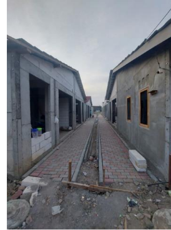
Pembangunan Rumah dengan Teknologi Ruspip
