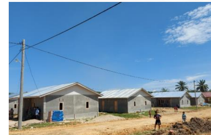
Permukiman Kembali- Kota Langsa
